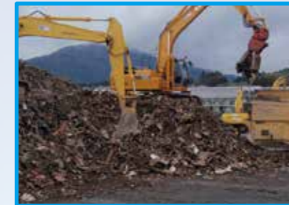
震災がれき・廃棄物の処理
